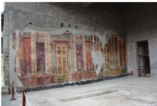
Mur de l'atrium
